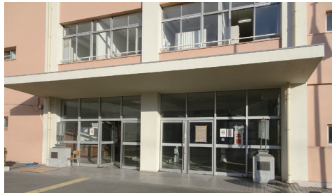
正面玄関全景
